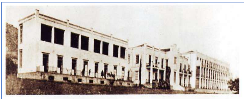
Figura 8 - Il sanatorio dopo il primo ampliamento del 1918.
