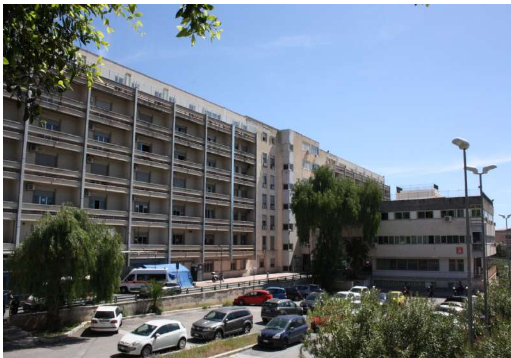
Figura 12 - Vista del fronte sud del Padiglione A "lineare multipiano" realizzato negli anni '80.
