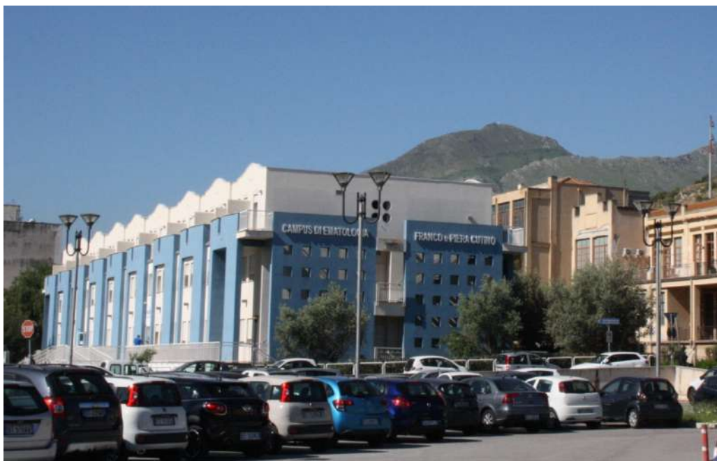
Figura 16 - Vista della Padiglione “Cutino”, in cui recentemente è stato realizzato il centro di cura della Talassemia e malattie rare del sangue.
