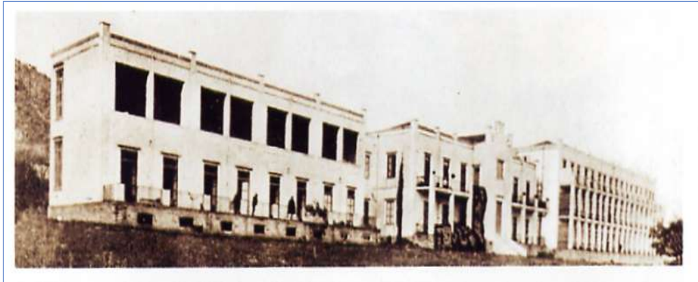
Figura 8 - Il sanatorio dopo il primo ampliamento del 1918.
