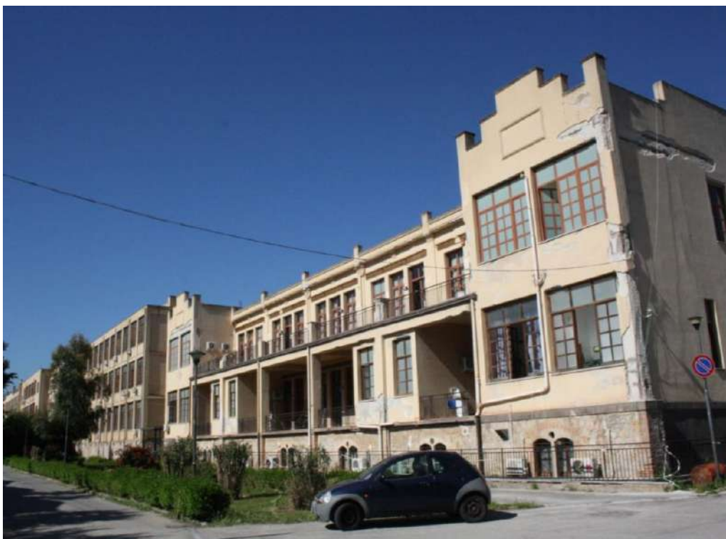
Figura 9 - Vista dell'ala più antica del Sanatorio costruito all'inizio del secolo scorso che, nonostante i notevoli segni di degrado e le trasformazioni subite, conserva ancora la sua forma originaria.
