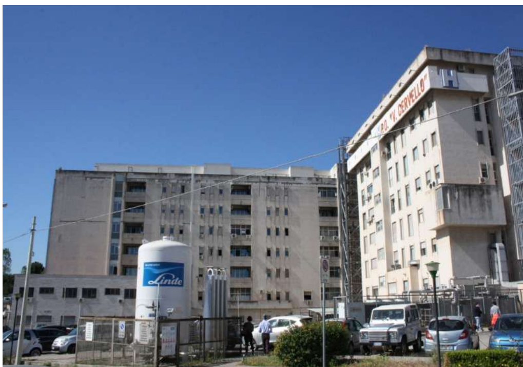
Figura 13 - Vista del fronte nord e di parte del corpo C dell'Edificio A che, rivolti dal lato opposto al centro Città, denotano una poca cura nel disegno e trascuratezza nella sua conservazione esteriore.
