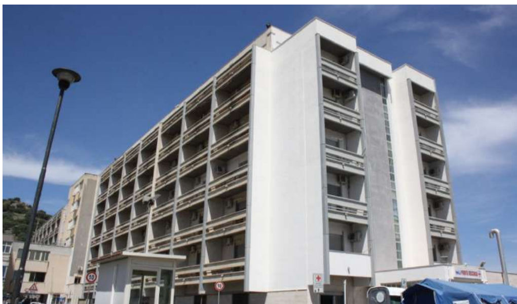
Figura 14 - Vista della testata est del Padiglione A, alla cui base è stato poi realizzato il Pronto Soccorso.
