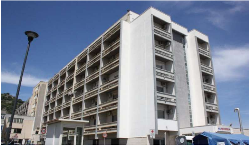
Figura 14 - Vista della testata est del Padiglione A, alla cui base è stato poi realizzato il Pronto Soccorso.
