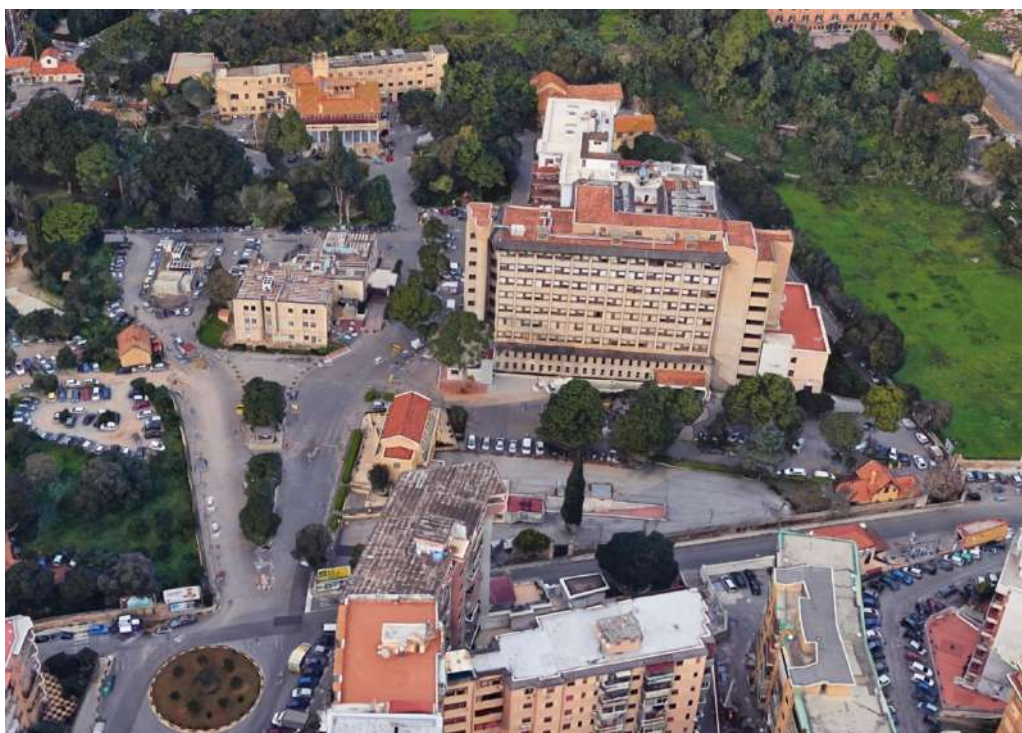
Figura 17 – Il P.O. “Villa Sofia”, a chiusura dell’asse nord di Palermo, su via Croce Rossa.
