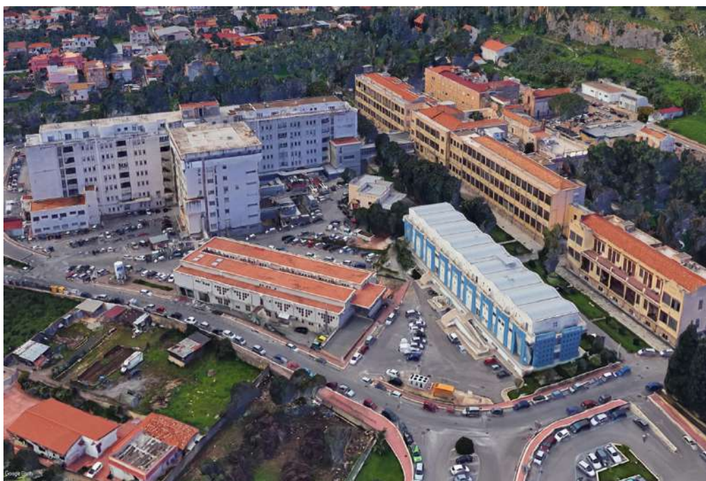
Figura 18 - Attuale configurazione, vista da nord, del complesso del P.O. "V. Cervello".
